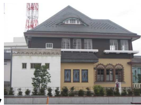
旧土岐家住宅洋館
