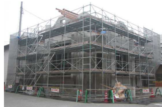
旧久米邸洋館工事中のようす
